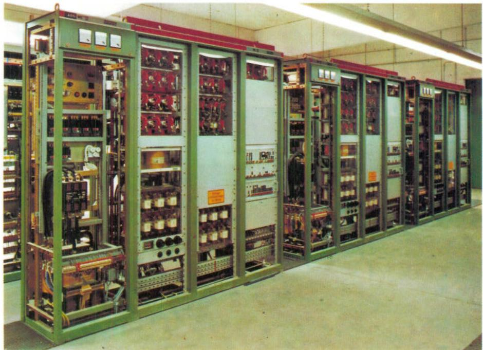
Bild 16.2.6 Drei statische Frequenzumrichter SEMIVERTER der AEG-TELEFUNKEN für Vierquadrantenbetrieb, Spitzenleistung je Umrichter 500 kVA, Frequenz bis 110 Hz, zur Speisung von Rollgangs-Getriebe-Motoren in der UMIT bei den Stahlwerken PEINE-SALZGITTER AG
