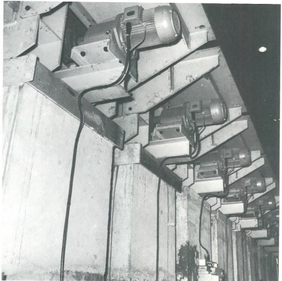
Rollgangs-Getriebe-Motoren in der
